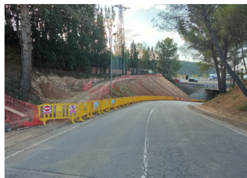
Imatge dels treballs al carrer Entroncament
