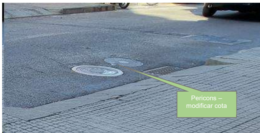
Pericons existents a adaptar a cota existent
