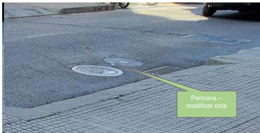
Pericons existents a adaptar a cota existent
