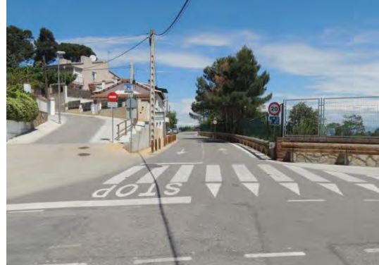
Plataforma elevada Camí de Terrassa
