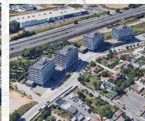
Edificis oficines Cami Ca n'Ametller
