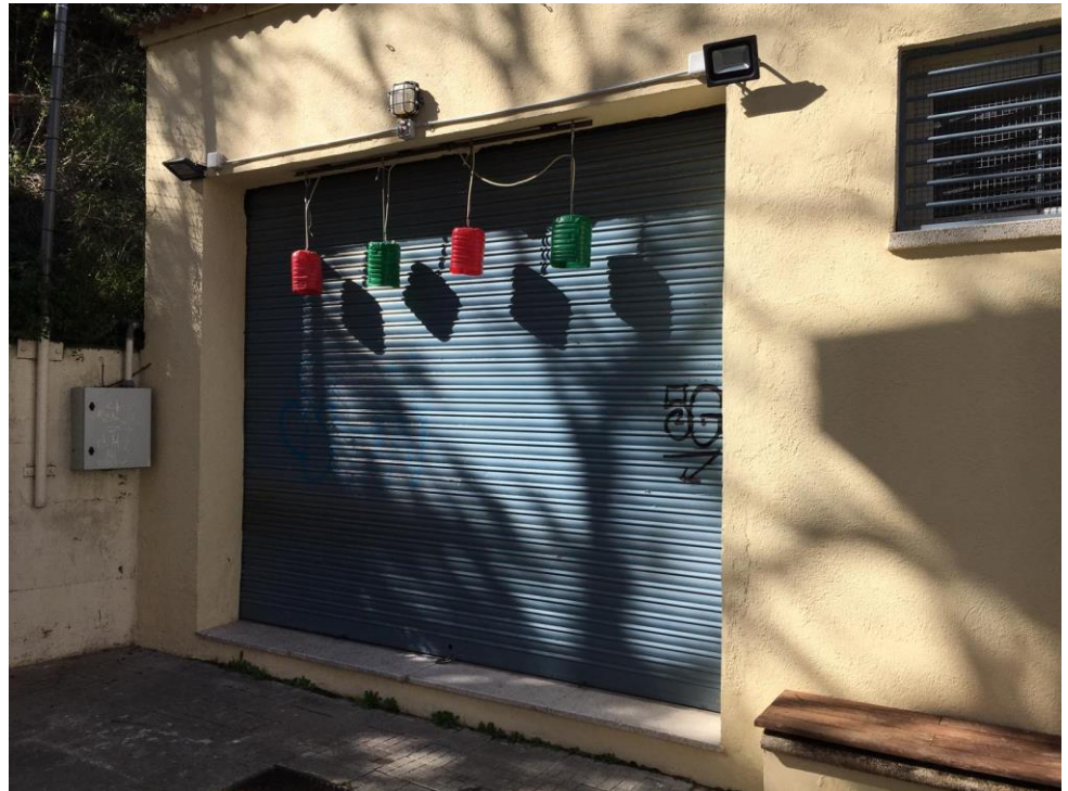
Instal·lació d'il·luminació exterior al Bar
