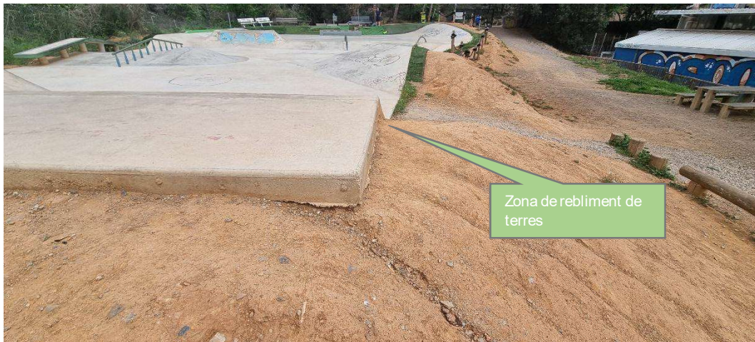
Rebliment del perímetre del skatepark actual, amb material de la pròpia excavació
