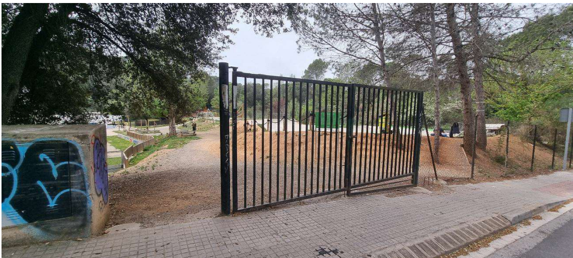
Accés a l'àmbit de les obres
