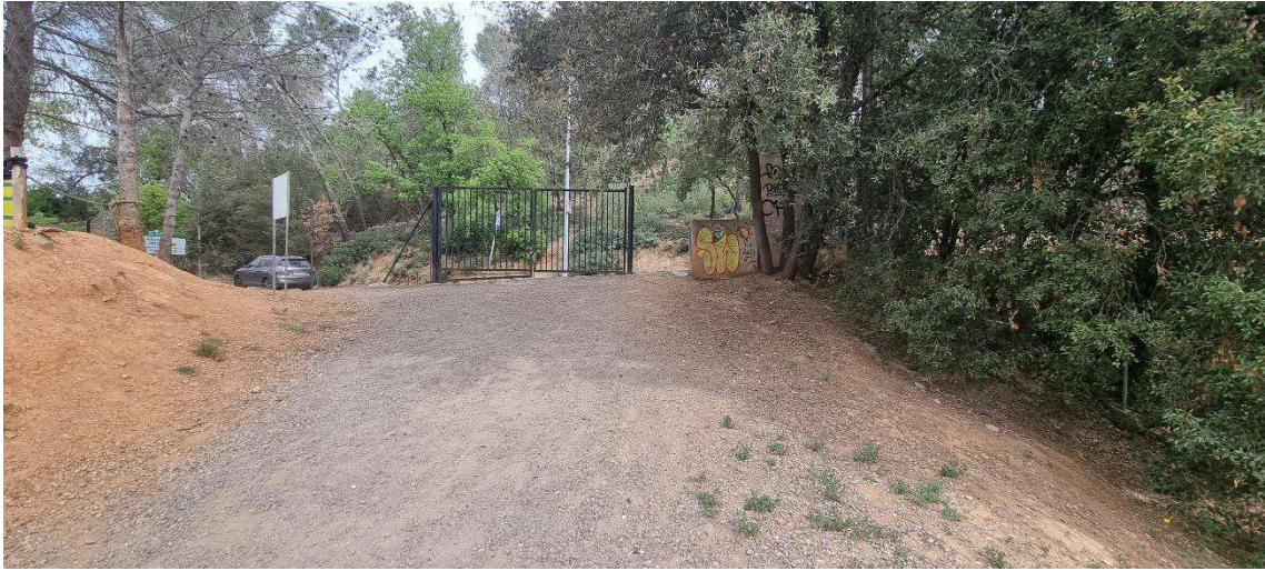
Accés a l'àmbit de les obres
