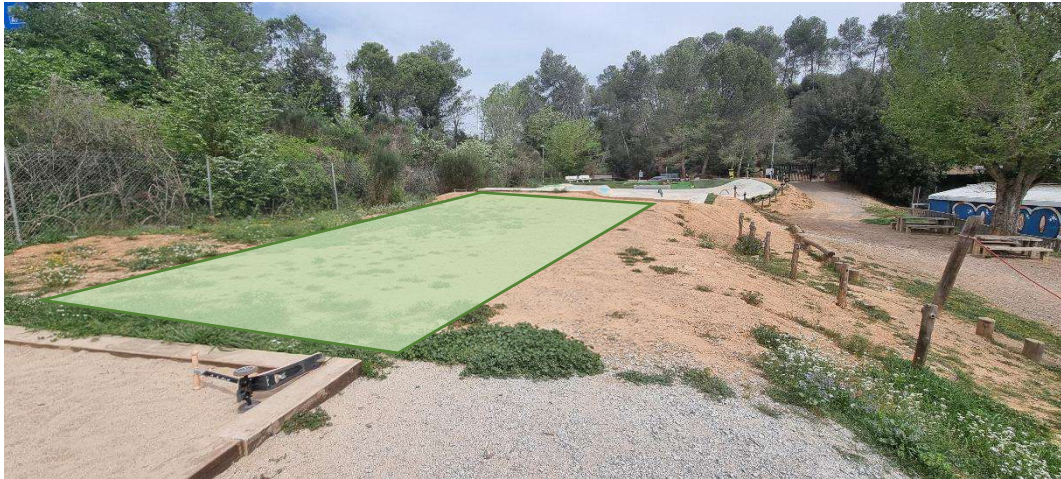
Zona d'excavació per executar l'skatepark
