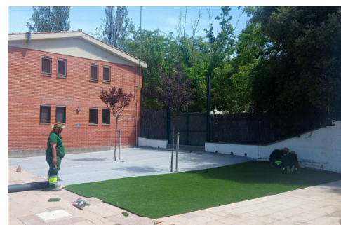
Imatge de les obres per substituir la gespa
