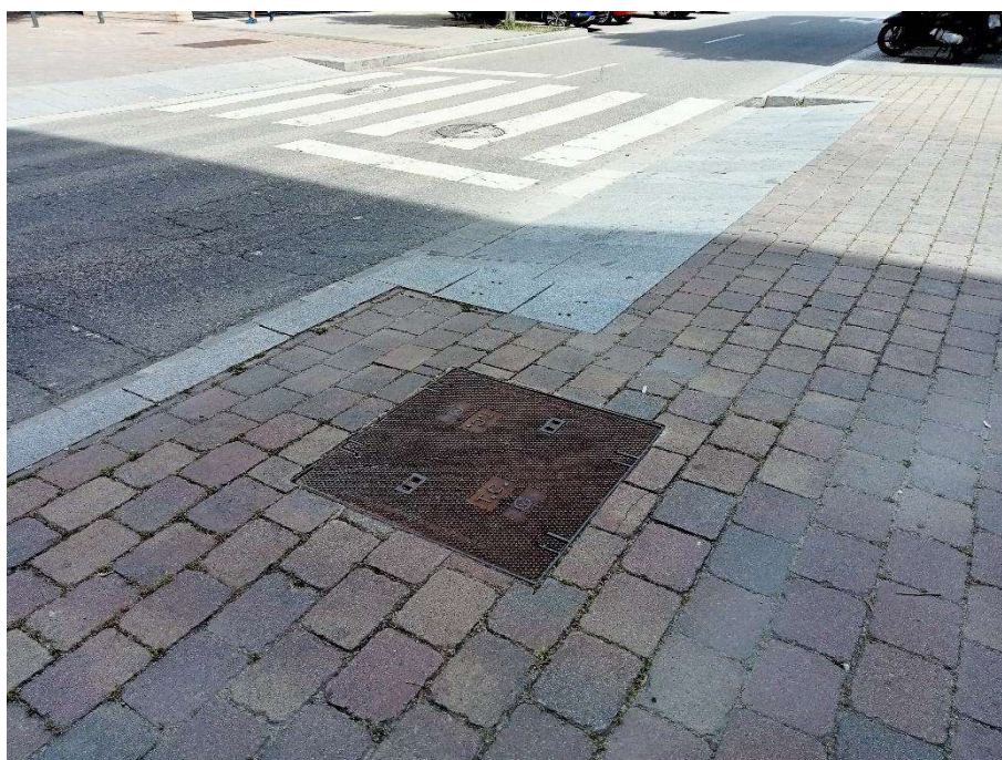
Vorera sud – pericó existent
