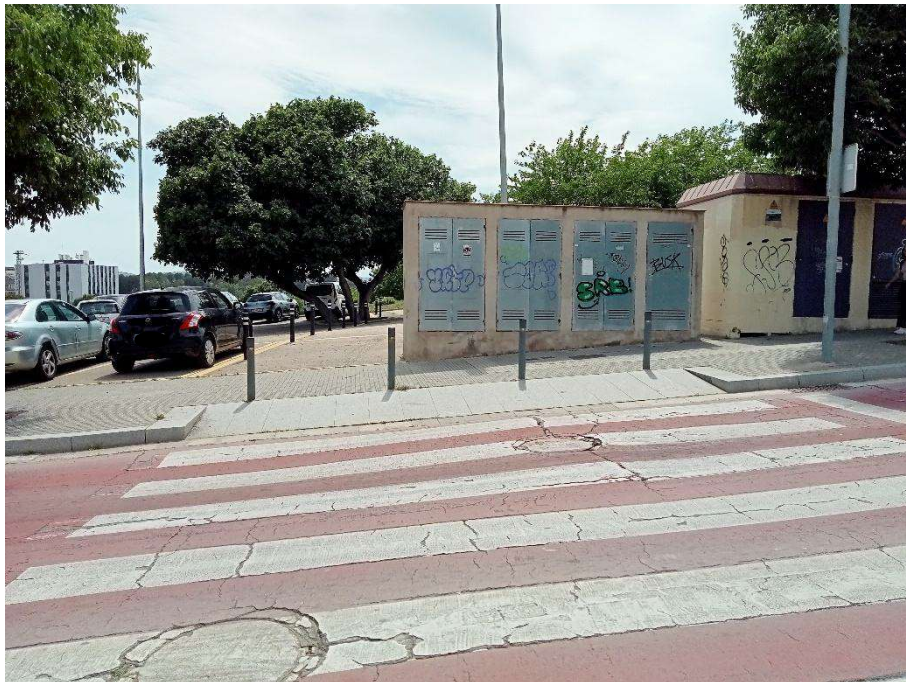
Àmbit d'actuació – des de vorera nord
