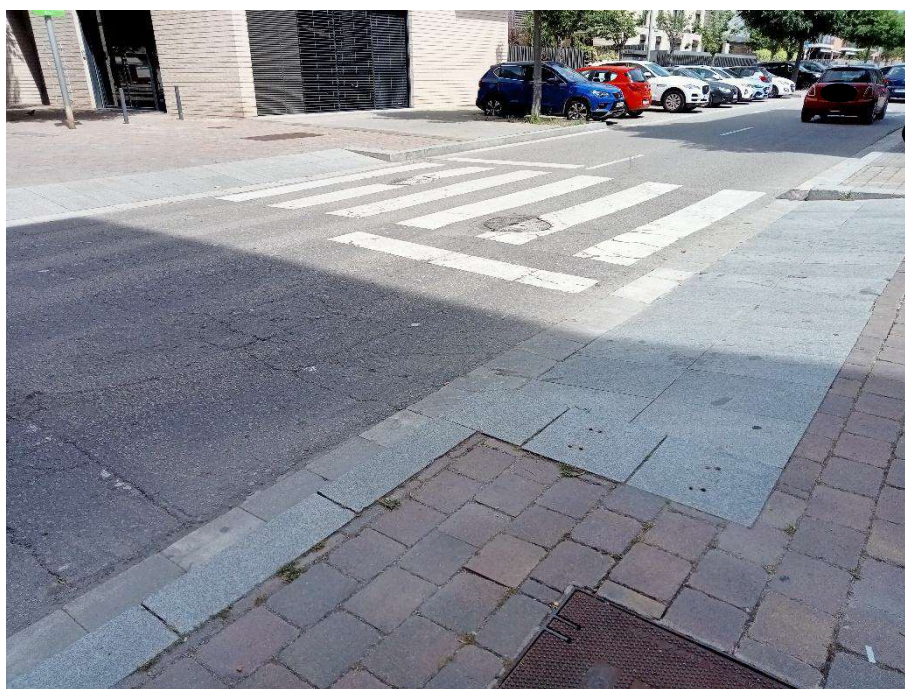
Vorera sud –gual a demolir
