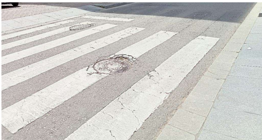
Pous clavegueram – adaptar cota a la de pas elevat
