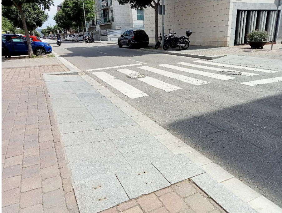
Àmbit d'actuació – des de vorera nord
