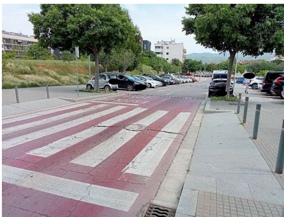
Vorera sud – gual a demolir
