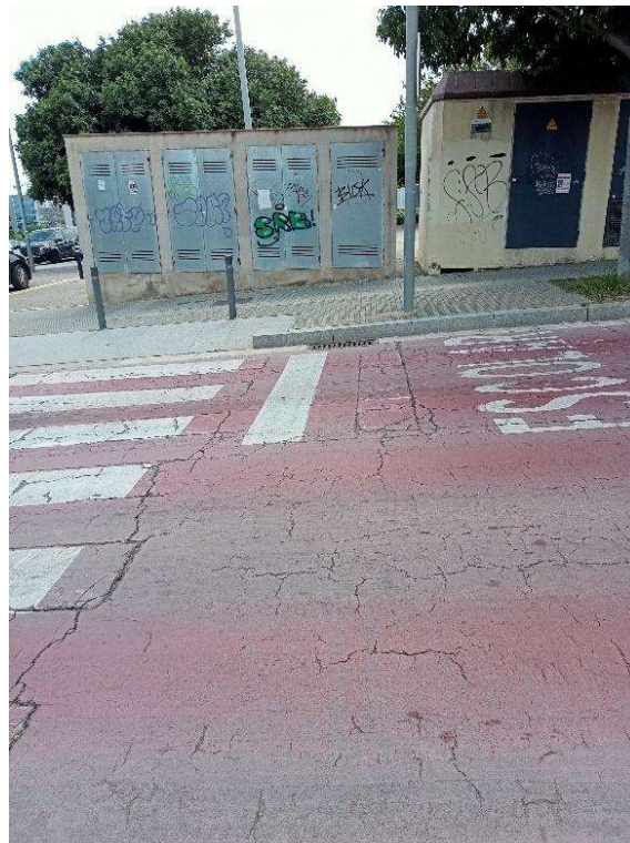
Vorera sud – quadres elèctrics existents
