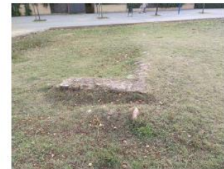
7. Murs de tancament est del Pati on s'observa morter degradat, fongs, falta de material per degradació i elements vegetals.
